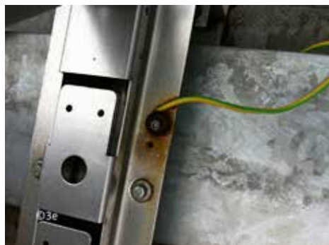
Fuente: Manual para mejorar la calidad y reducir el coste de los sistemas fotovoltaicos
