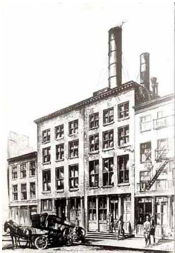
PRIMERA CENTRAL ELÉCTRICA.
