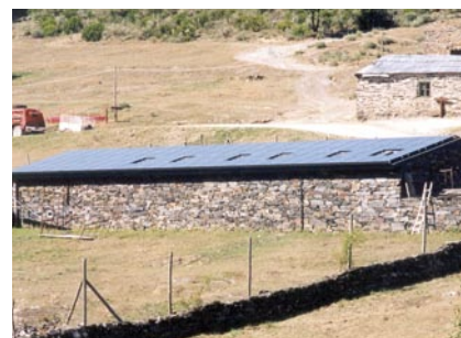
Fig. 3. Campo FV en el tejado.
