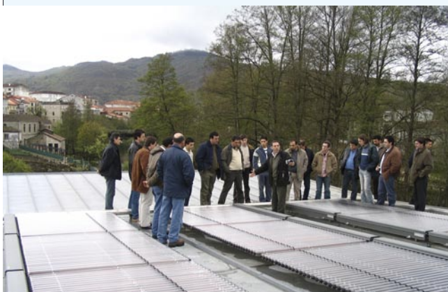
Sobre la cubierta del Complejo Polideportivo de Allariz, el profesor, Manuel Vázquez, realizando una detallada descripción de las características de los paneles solares.
